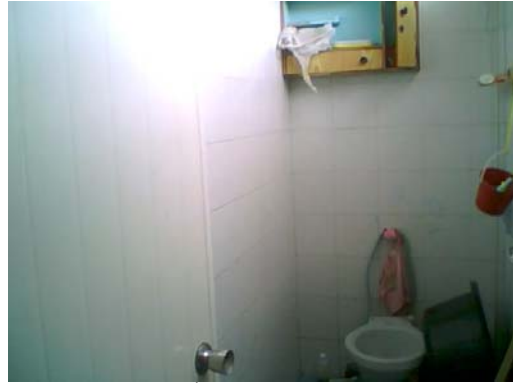
รูป10 ห้องน้ำอยู่ในบริเวณห้องนอน
